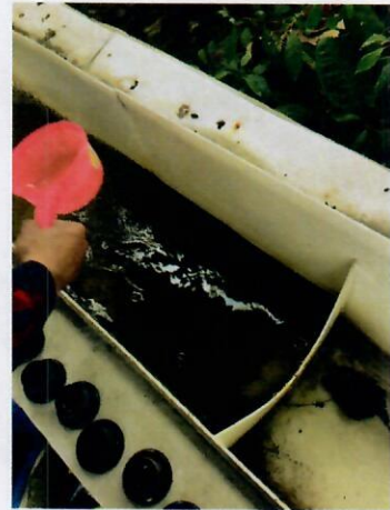
污水处理站出口
